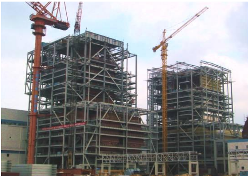
图 5：建设中的电站锅炉
