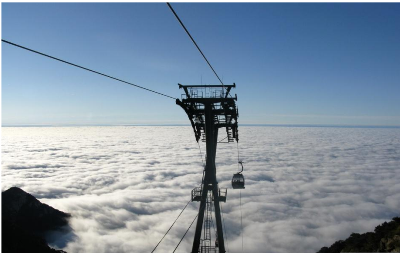
图 14: 客运架空索道
