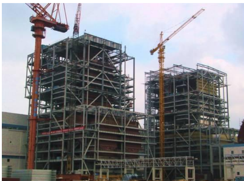
图 5：建设中的电站锅炉
