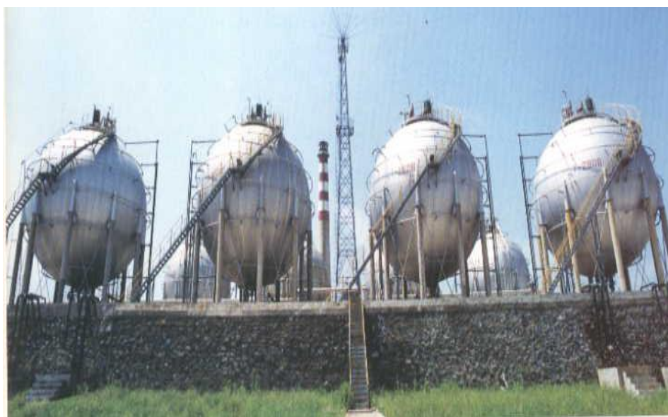
图 7：固定式压力容器（球形储罐）
