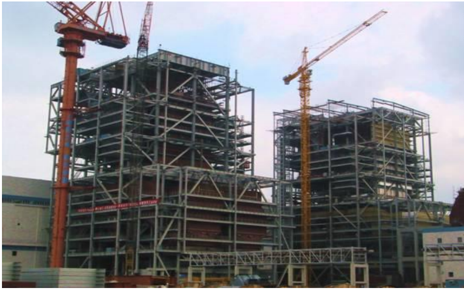
图 6：建设中的电站锅炉
