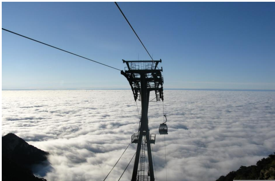
图 15：客运架空索道
