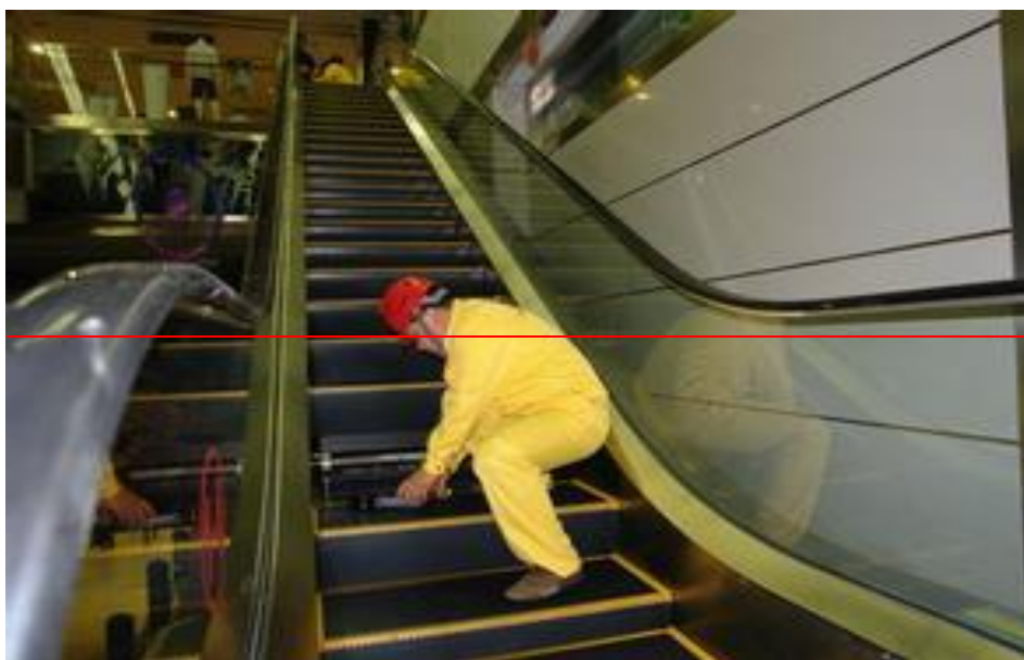
图 24：检验人员在对电梯进行检验
